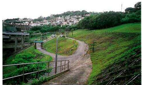
●傾斜を緩やかに処理し、小段を遊歩道に仕上げ、ベンチ、水飲場等を設置するなど親しみのある空間として整備されている。(那覇市 識名)
