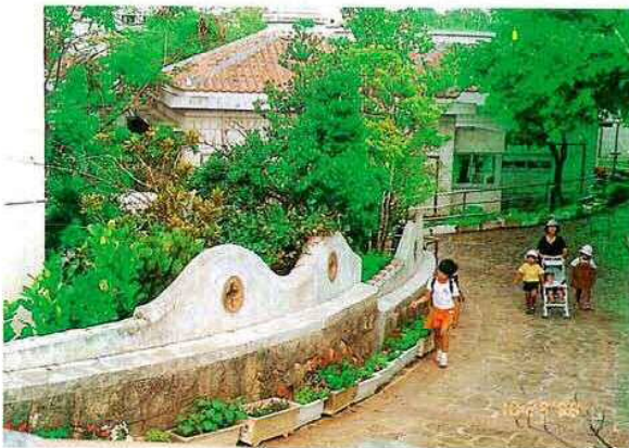
● 舗装や擁壁、障壁などの構造物は、親しみのあるイメージとする。 (那覇市、首里)
