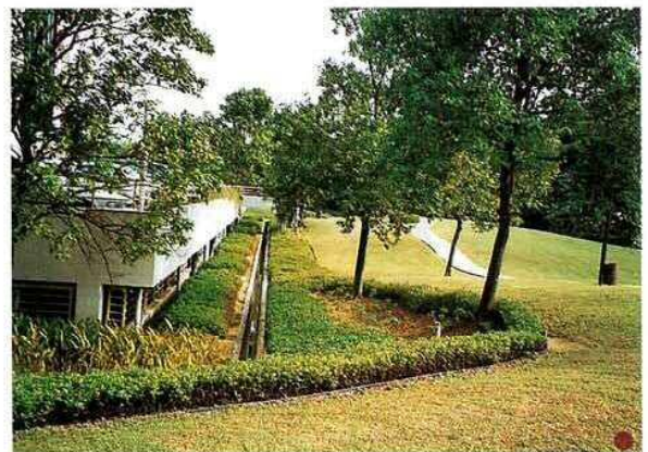
● 立体駐車場を半地下とし、施設周りを緑化している。 (シンガポール)
