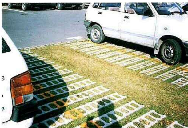
● 透水性に配慮したブロック舗装により芝張りの駐車場を実現している。 (宜野湾市、真志喜)
