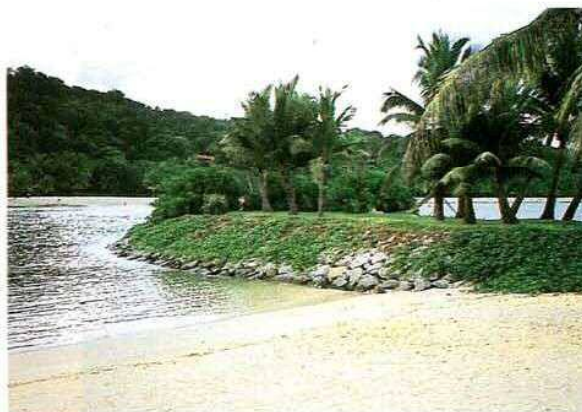
●海岸の構造物にも積極的に緑化することで、周辺自然域となじんでいる。 (シガポール)
