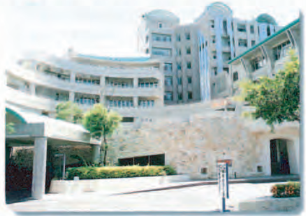
曲線を使ったコンクリートの造形と各種素材が融合して、やわらかいイメージを作り出している。 （県自治研修所・女性総合センター、那覇市）
