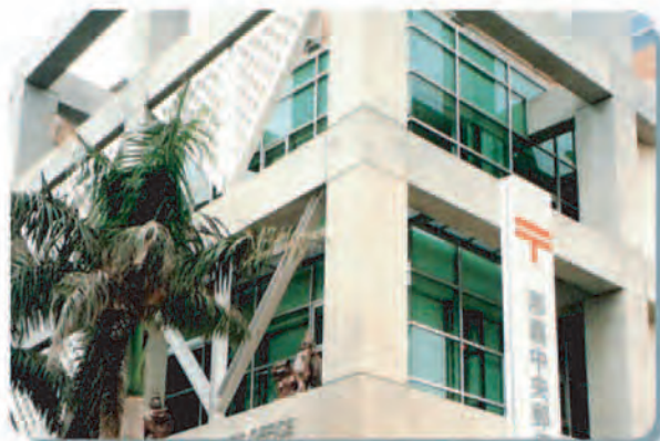
施設の正面には、金属パネルや金属フレームを効果的に使用し、コンクリート、石材、ガラスなど他の素材と調和し印象的なデザインとなっている。 （那覇中央郵便局、那覇市）
