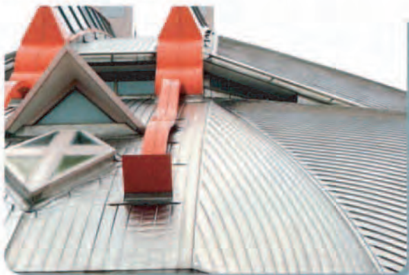
沖縄の厳しい気候・風土に負けない合金をシンボリックな屋根に使用している。 （県立武道館、那覇市）
