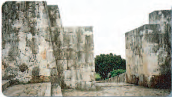
琉球石灰岩の「布積み」、「あいかた積み」の2つの工法を混合して積まれた石積みである。 (首里城、那覇市)
