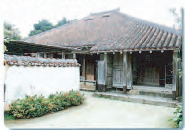
イヌマキ（方言名：チャーギ）は、沖縄県内（大東島を除く）では各島の山地に点在し、住宅用材として広く使用されてきた。 （宮良殿内、石垣市）
