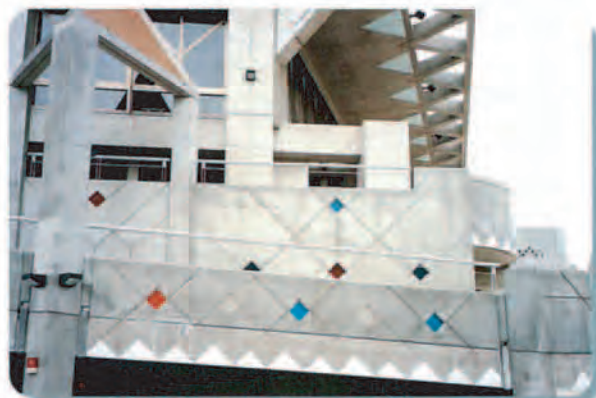
コンクリート打ち放しの壁面にアクセントとして、様々な色の琉球ガラスがはめ込まれている。 （県立武道館、那覇市）
