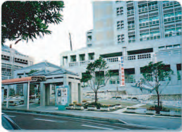
方形のマスブロックを巧みにデザインして、個性的な景観をつくり出している。 （浦添市役所、浦添市）
