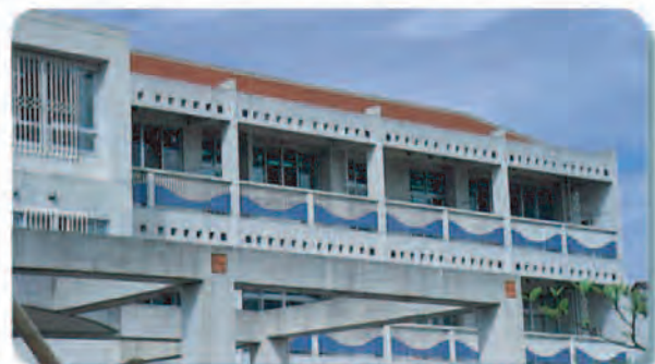
重ね瓦は、スマートなデザインに調和し、住宅等を中心に幅広く使用されている。 (美咲養護学校、沖縄市)
