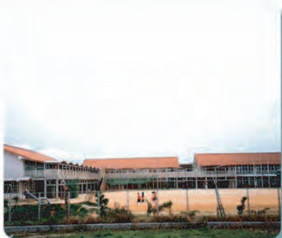
③ 前面にオープンスペースを確保し、屋根部分もスカイラインに配慮した勾配を持たせている。 (八島小学校 石垣市)
