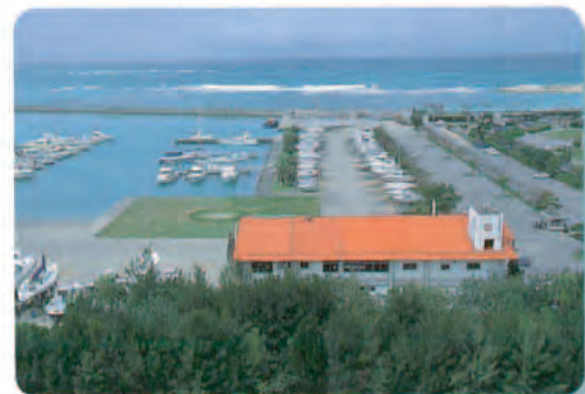
③ 全体的に整った建物は、海岸域とのバランスを考慮し、落ち着いた景観を保っている。 (宜野湾港マリーナ、宜野湾市)
