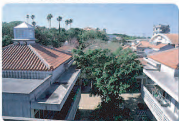
② 赤瓦、集落イメージの採用により、地域の歴史的建築物との調和が図られている。 (城西小学校、那覇市)
