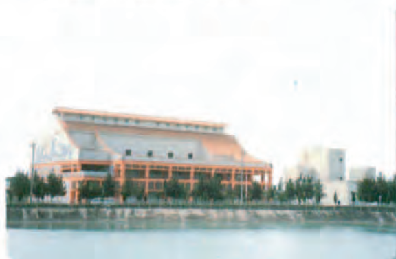
③ 施設を機能別に分棟することにより、高さを抑え後背地の海岸域への見通しの配慮がなされている。 (県具志川浄化センター、具志川市)
