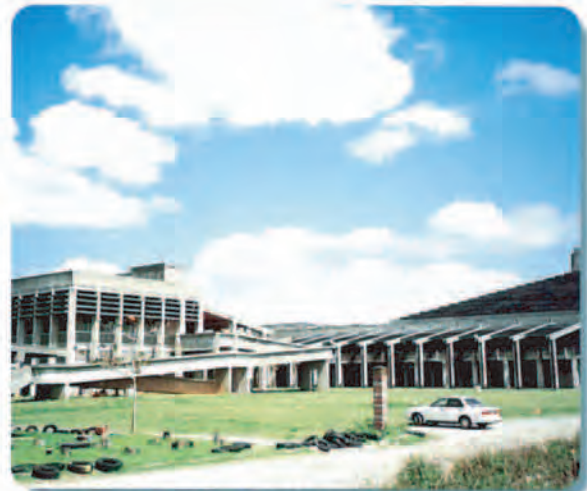
① 海浜部に面した位置にあり、敷地内に十分な空き地を確保し、開放的な景観を形成している。 (名護市民会館、名護市)
