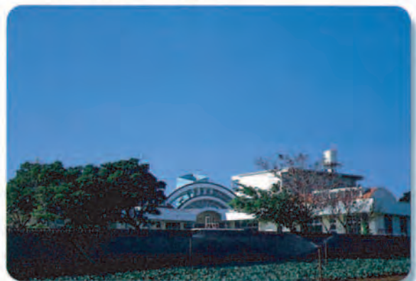
② 集落のスケールと違和感がなく、建物の形態についても周辺景観になじんでいる。 (宜野座村立保育園、宜野座村)
