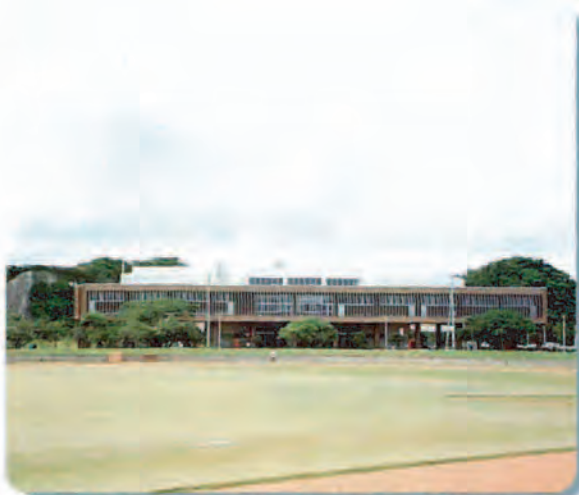
① 背後の岩壁の丘陵地との連続性を意識した高さ、色彩で建物正面を工夫している。 (具志川市立総合体育館 具志川市)
