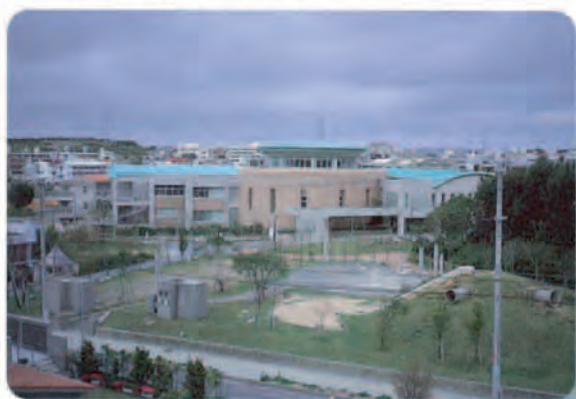
⑤ 地区計画により誘導される地域の景観形成拠点となっている。 (那覇市総合福祉センター、那覇市)
