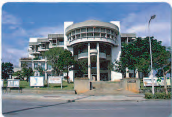
⑥ 沿道からのセットバック、正面に対しての象徴性等デザインの工夫がなされている。 (具志川市役所、具志川市)
