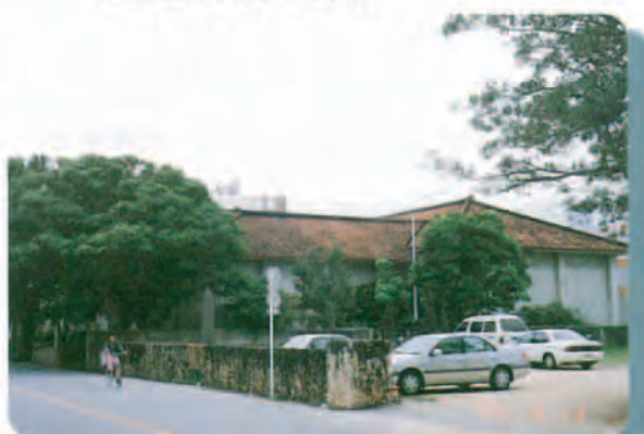
③ 周辺の建物との規模や建築デザインに配慮し、調和のとれた景観となっている。 (八重山博物館、石垣市)
