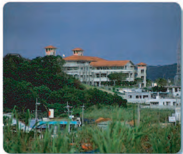
② みどり豊かな立地環境にあって、地形と調和した配置により周辺景観への配慮がなされている。 (翔南小学校、南風原町)
