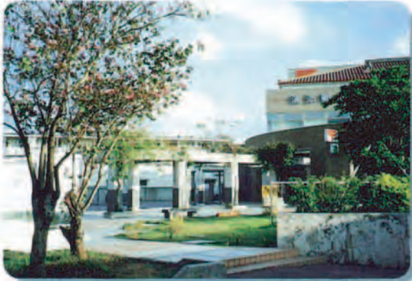
④ 中心市街地でオープンスペースを設けることにより、開放性のある景観を創出している。 (浦添郵便局、浦添市)
