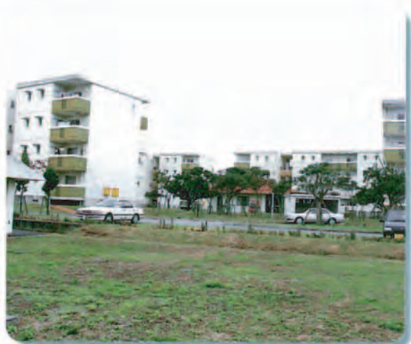
③ 高さを抑え、分棟化することにより、圧迫感の軽減が図られ、またやわらかな色使いが行われている。 (県営西里団地、平良市)
