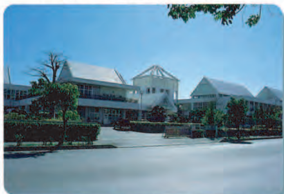
② 敷地回りの擁壁が閉ざされた感じがなく、沿道の景観となじんでいる。 (西崎養護学校、糸満市)
