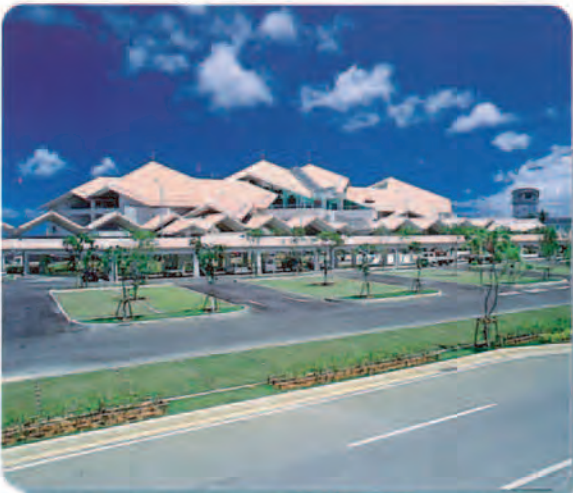
④ 分棟、赤瓦屋根を用いることにより、親しみある、地域に根ざした工夫がなされている。 (宮古空港新ターミナルビル、平良市)
