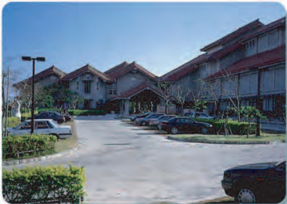
分棟、勾配屋根によりボリューム感を軽減した構成は、違和感のないまとまりのあるものとなっている。 (県立公文書館、南風原町)
