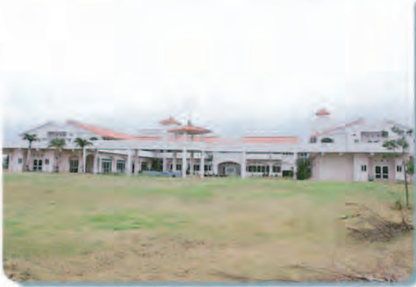
低層で勾配屋根の建築物が敷地境界の盛土で囲まれ、低く柔らかな敷地が自然に道路とつながっている。 (宮古厚生園、平良市)
