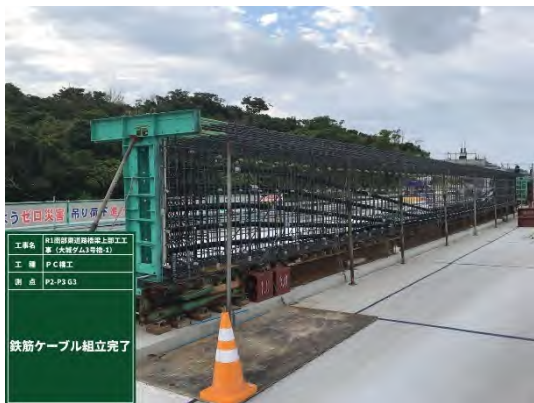
図 8.13 鉄筋組立状況
