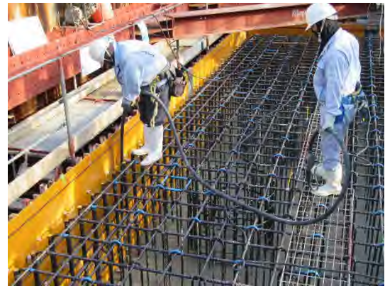
写真 8.30 下部工フーチング打設状況
