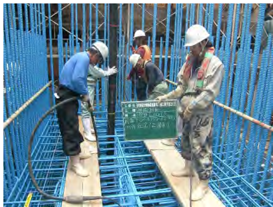
写真 8.5 本体橋梁部 下部工（橋脚）打込み状況
