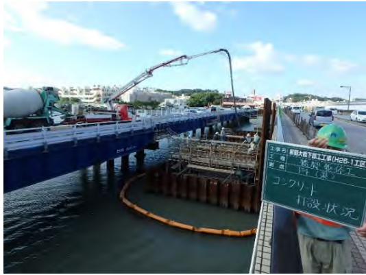
写真 8.7 下部工橋脚 打設状況
