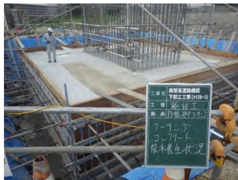
写真 8.12 散水養生状況
