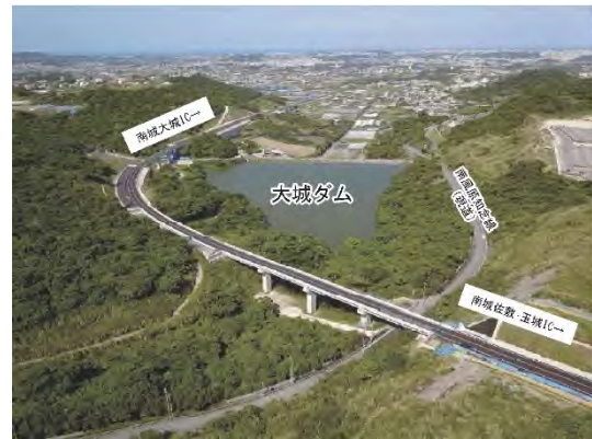
大城ダム付近
