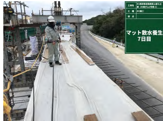
図 8.16 マット散水養生
