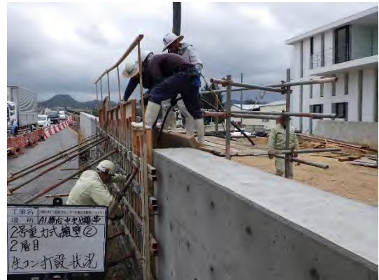
写真 8.23 重力式擁壁打設状況
