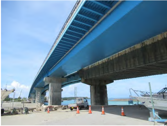
写真 8.18 A2 橋台側から撮影
