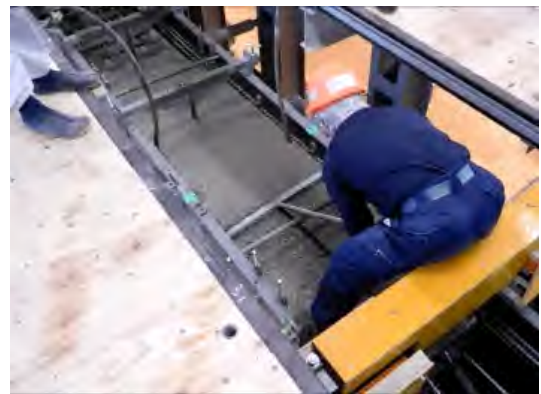
写真 8.35 締固め状況
