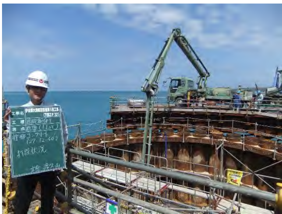
写真 8.5 本体橋梁部 下部工（橋脚）打込み状況
