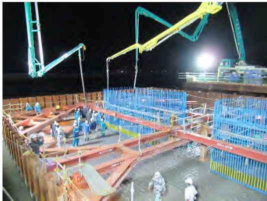
写真 8.30 下部工フーチング打設状況
