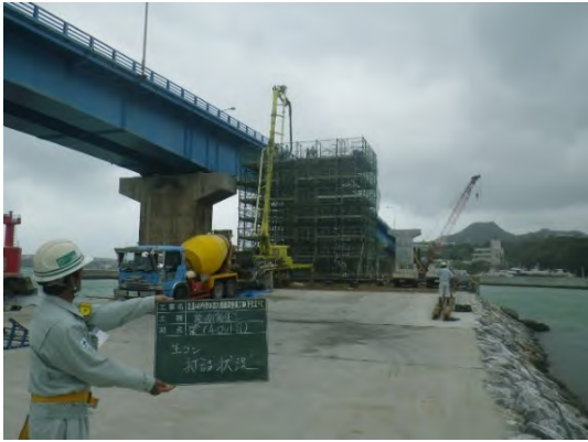
写真 8.22 橋脚打設状況
