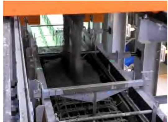
写真 8.34 バケットによる生コン打込み状況
