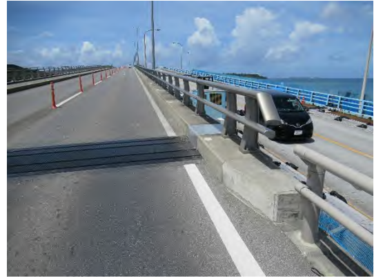
写真 8.19 地覆コンクリート
