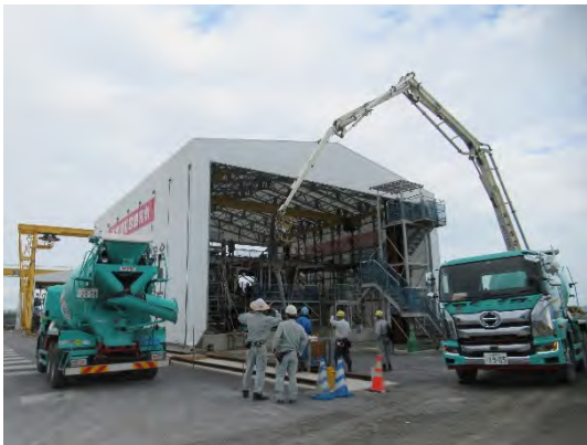
写真 8.32 上部エセグメント打設状況
