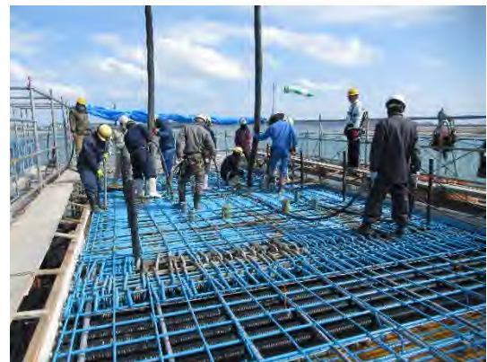
写真 8.31 上部工柱頭部打設状況（左：1Lot 目、右：2Lot 目）
