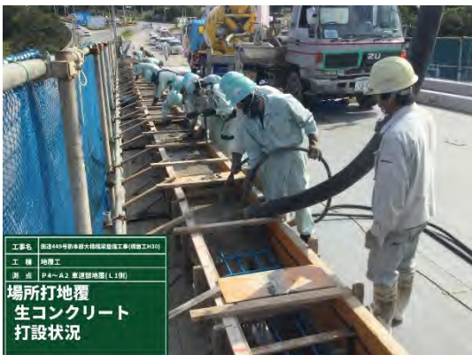
写真 8.24 地覆コンクリート打設状況
