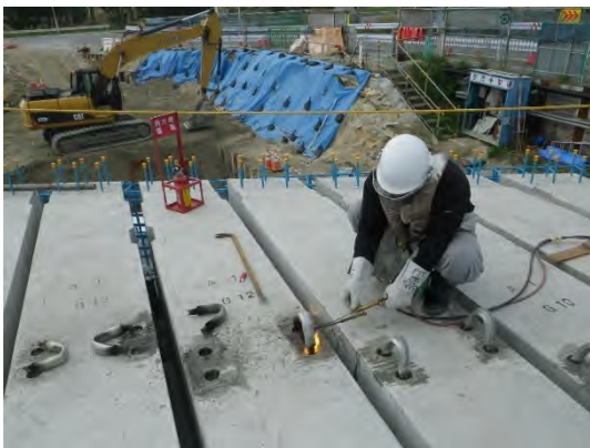
写真 8.28 吊り金具切断状況
