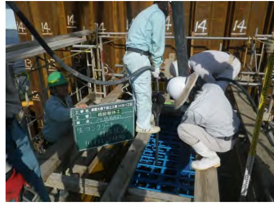
写真 8.7 下部工橋脚 打設状況
