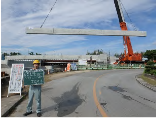
写真 8.27 上部工桁架設状況
