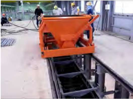
写真 8.34 バケットによる生コン打込み状況
