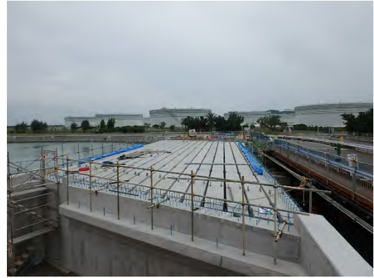
写真 8.27 上部工桁架設状況
