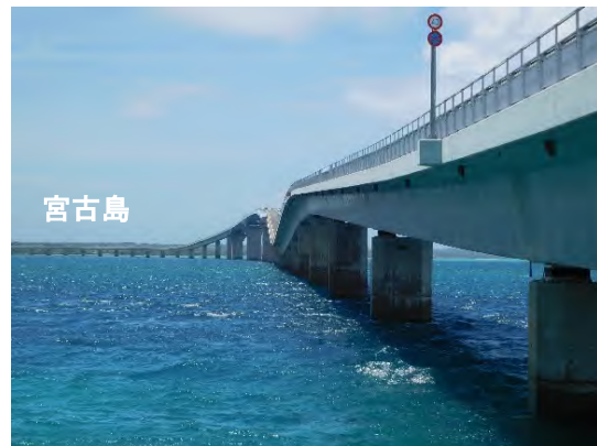
写真 8.3 橋梁全景（伊良部島側から）
