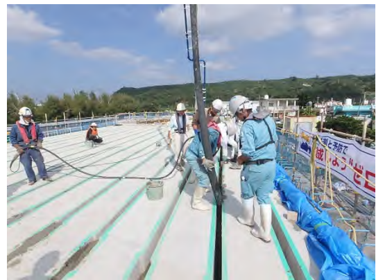
写真 8.29 間詰めコンクリート打設状況
