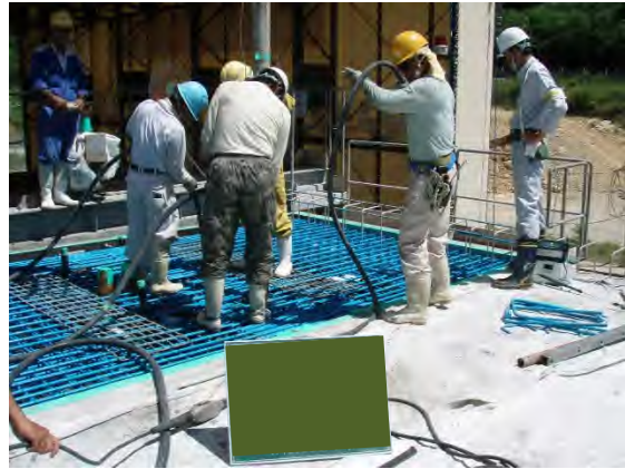
写真 8.4 本体橋梁部 上部工（PC箱桁セグメント）打込み状況
