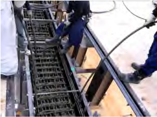
写真 8.35 締固め状況
