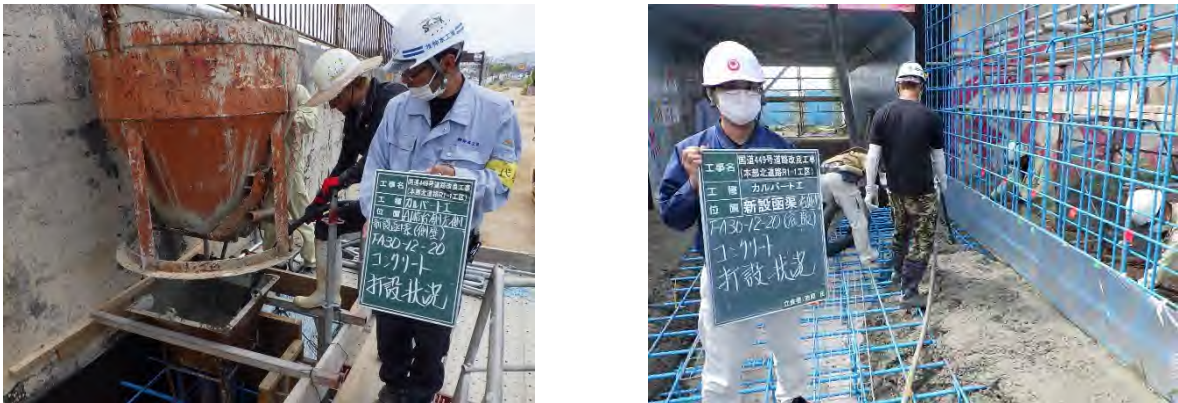
写真 8.25 ボックスカルバート打設状況
