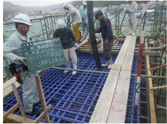
写真 8.22 橋脚打設状況
