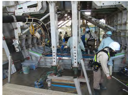
写真 8.32 上部エセグメント打設状況
