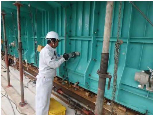
図 8.15 型枠バイブレータによる締固め状況
