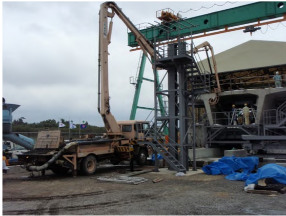
写真 8.4 本体橋梁部 上部工（PC箱桁セグメント）打込み状況
