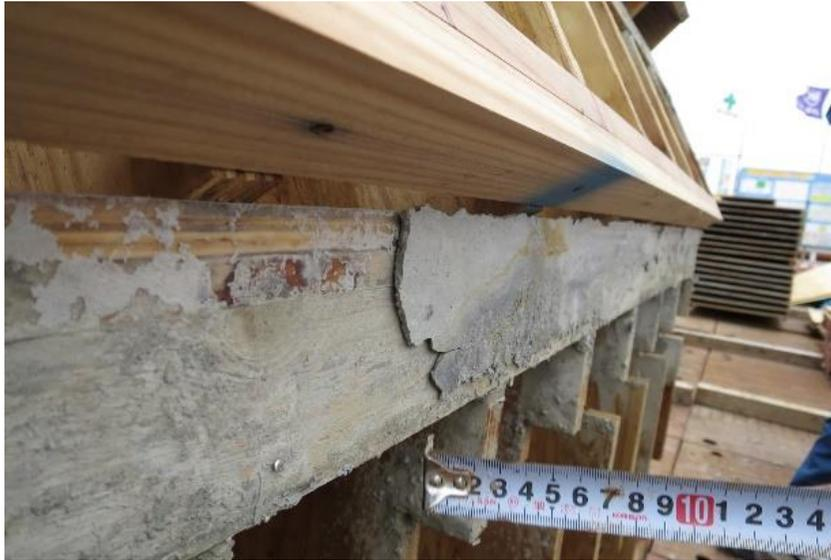
写真10.7 型枠継ぎ目でノロが固まった状況
