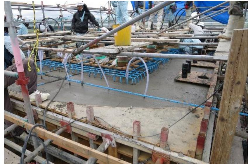
写真10.8 型枠を支保工で固定している状況
