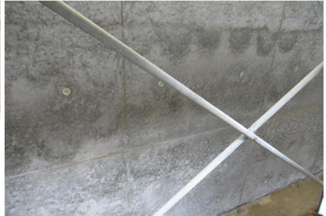
写真10.3 バイブレータ過挿入による
