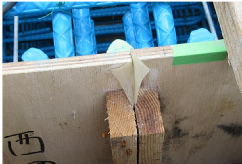
写真10.9 ノロ漏れ防止テープを型枠両側に貼り付けた状況
