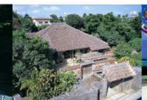
宮良殿内（石垣市）
