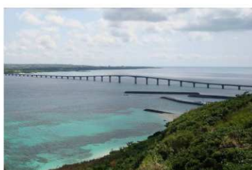
来間大橋（宮古島市）
