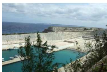
堀り込み漁港（南大東村）
