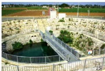
地下ダム（宮古島市）
