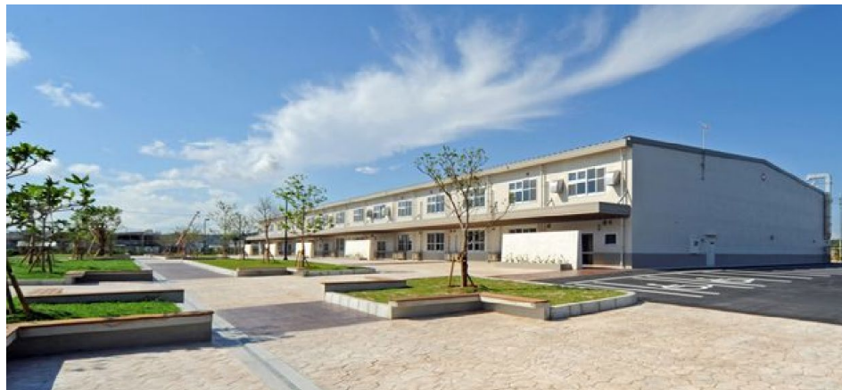
外構は敷地廻りに地被を配置して道路側から開放した空間を演出し、中核工場と関連工場の間には、高木とベンチ等を配置し作業員が休息できるように配慮されている 沖縄特別自由貿易地域高度技術製造貿易賃貸工場（うるま市）
