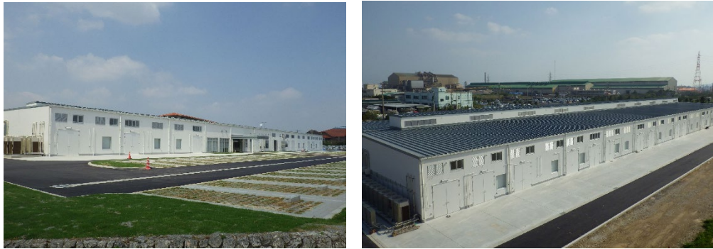
雨樋を壁面と同色にすることにより、露出しても目立たない 沖縄先端生命科学研究所（うるま市） 出典：* 3
