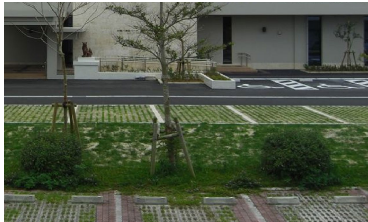
駐車場の緑化ブロックと植栽により駐車場のアメニティを確保するとともに、隣接地と連続させている
