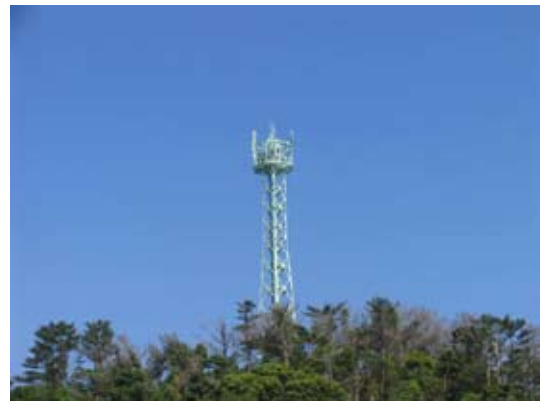
周囲から浮いてしまっている鉄塔。配置や色彩を誘導する指針があれば、重要な景観ポイントに建設してしまうことや不調和な意匠を防ぐことができる。
