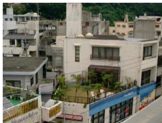
シンノウヤシや芝生が植栽された屋上（那覇市）
