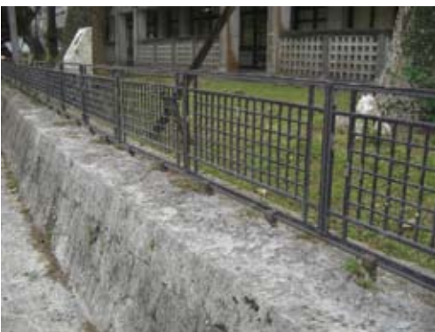
擁壁等の高さを最小限にし、上部は透過性のあるフェンスを用いて明るく親しみのある景観を形成している事例
