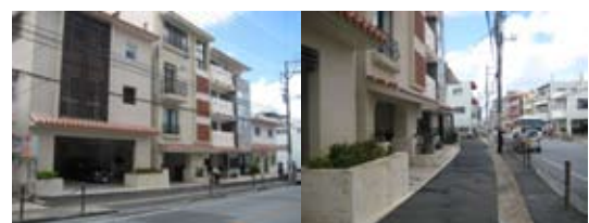
建物1階部分を庇により分割して、低層部分の構成を強調しながら、歩行者空間を個性的に演出している。
