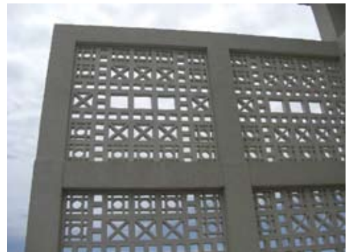
沖縄の地域素材であり気候風土に適した花ブロック。組み合わせパターン、活用場所には多様なバリエーションがある。
