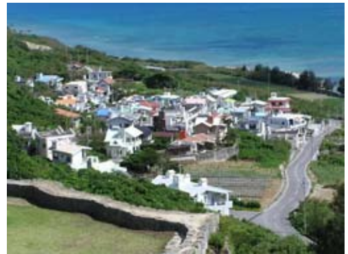
中景俯瞰の既存集落の景観 俯瞰景観では屋根形態だけでなく、色彩なども重要となる。重点的な地区では、高架水槽などの付属物も検討する必要がある。
