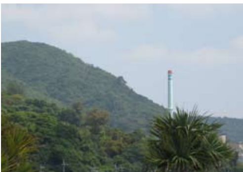
自然景観での煙突の修景事例。色彩をそら色とすることで修景を図っている。
