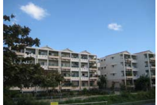
4階程度以上の建物では屋根は見えないと思われがちだが、傾斜地形の場合や視距離によっては道路からも屋根面が視認される。
