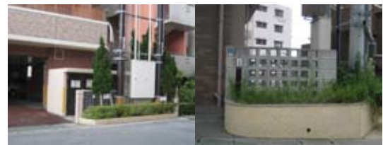
修景したゴミ置場の事例 建物と一体的なデザイン、目隠しなどによる修景
