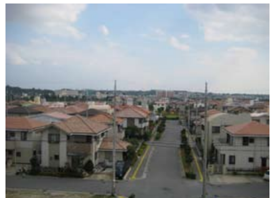
勾配屋根をルール化した地区。まちなみに一定のリズム感、統一感がある
