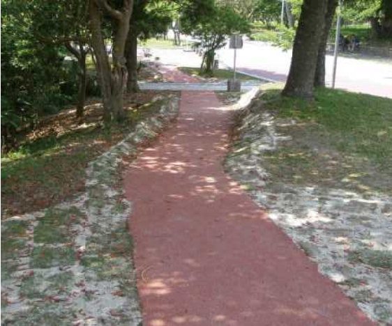
浸透系舗装材を使った歩道
