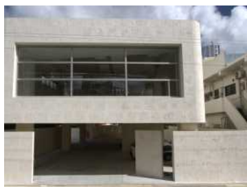
外壁に使用した例
