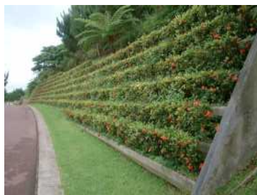
法面を緑化した例
