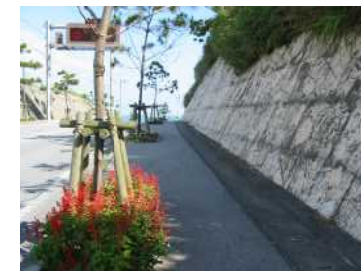
道脇擁壁として使用した例
