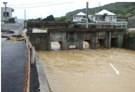
写真 製糖工場取水堰撤去前
