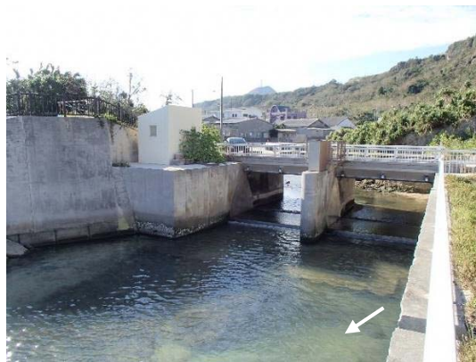
写真 改築後の河口水門（H16改築）
