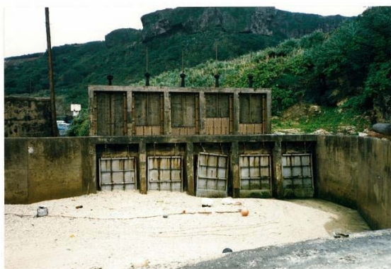
写真 改築前の河口水門
