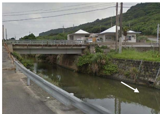
写真 製糖工場取水堰撤去後（H20撤去）
