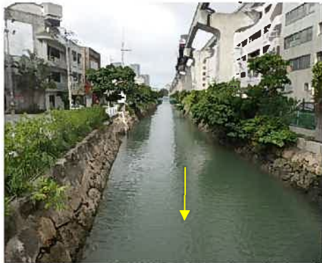
写真 1.9 美栄橋上流 (1k600 付近)
