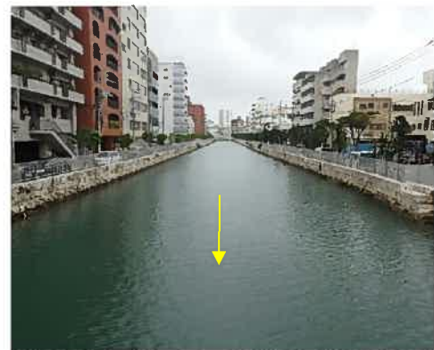
写真 1.6 中之橋上流 (0k400 付近)
