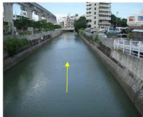
写真 1.5 安里新橋下流 (0k900 付近)
