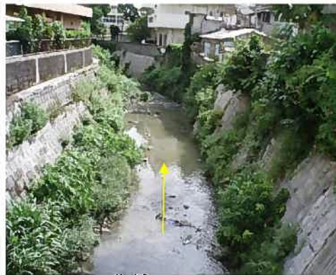
写真 1.3 大道橋下流 (2k800 付近)
