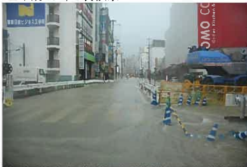
写真 2.1 国際通り浸水状況
