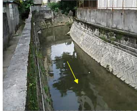
写真 1.8 県道 29 号線上流 (0k300 付近)
