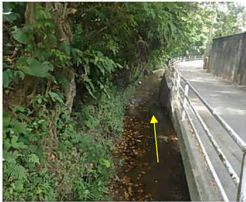
写真 1.1 金城ダム上流 (7k000 付近)
