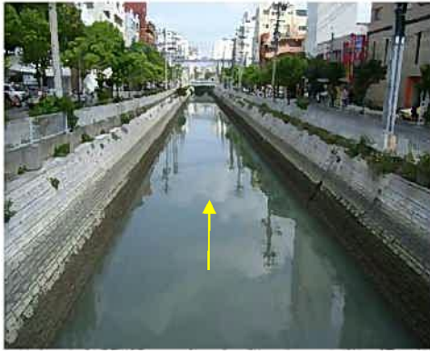
写真 1.11 潮渡橋下流(0k800 付近)
