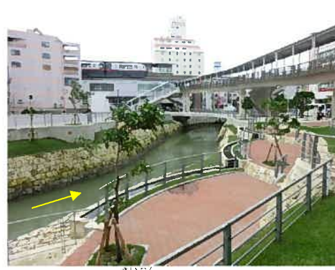
写真 1.4 蔡温橋上流 (1k300 付近)
