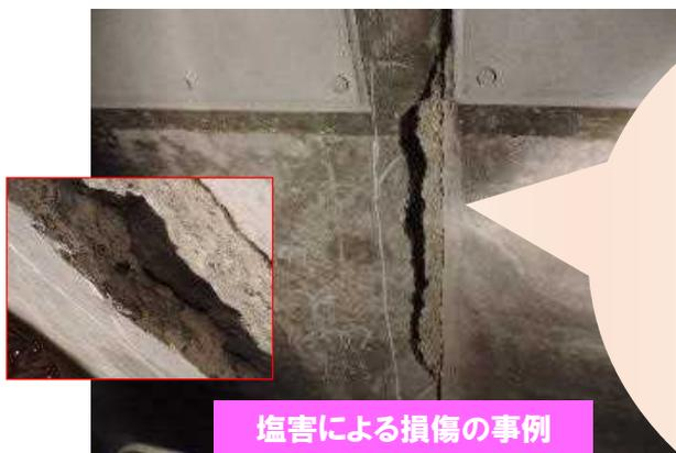
塩害による損傷の事例
