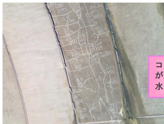
コンクリートにひび割れが生じ、目地部などより漏水が確認できる
