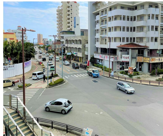
図 2-4 国道 390 号 (石垣市) 整備後
