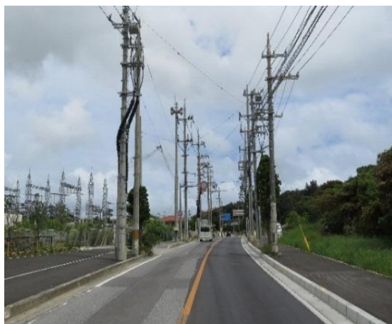
図 2-7 県道 16 号線（うるま市） 整備前
