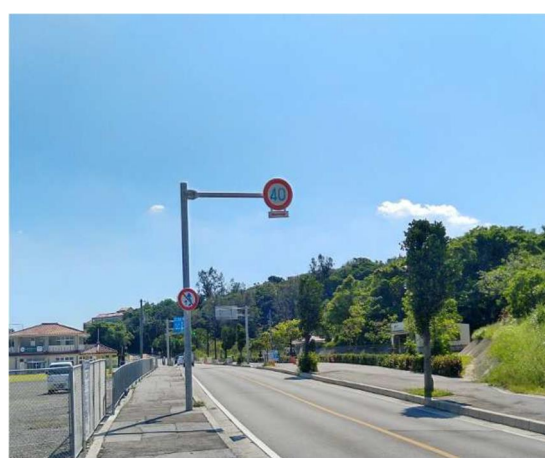
図 2-8 県道 16 号線（うるま市） 整備後
