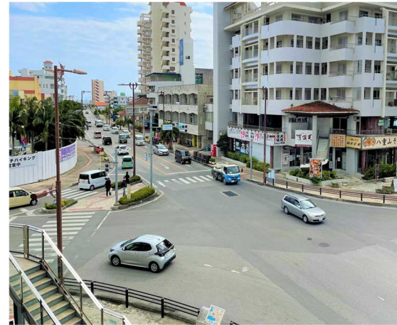
図 2-4 国道 390 号 (石垣市) 整備後
