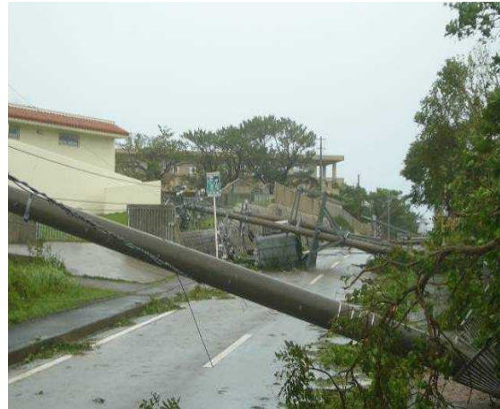
図 2-2 平成 18 年 台風 13 号 (石垣市)
