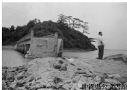
図 2-5 屋我地大橋倒壊状況 (1960年チリ津波)
