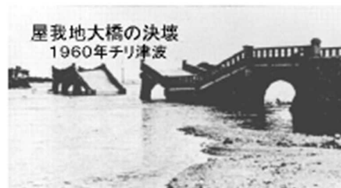
図 2-5 屋我地大橋倒壊状況 (1960年チリ津波)
