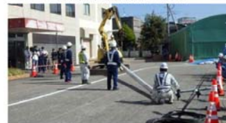
バックホウによる電柱撤去
