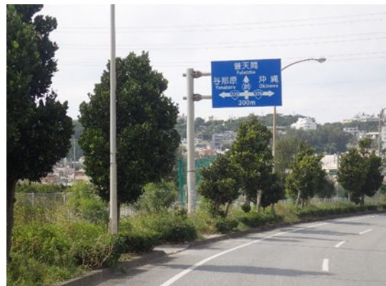
写真 2-2 片持式(F型)道路標識
