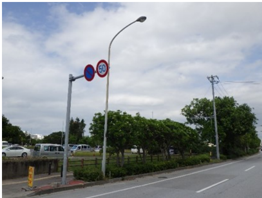
写真 2-1 片持式(逆L型)道路照明
