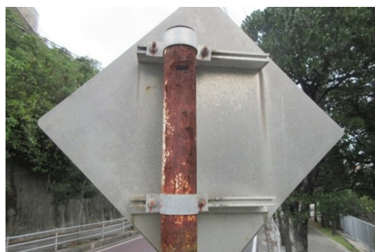
写真 2-4 補修または更新の検討が必要な事例
