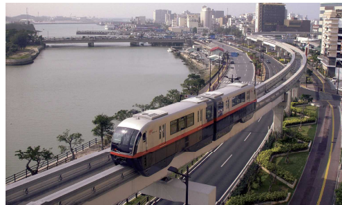
壺川付近を走行するモノレール
