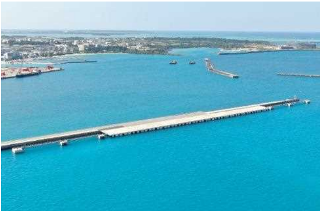
▲クルーズ岸壁（出典：宮古島市）
