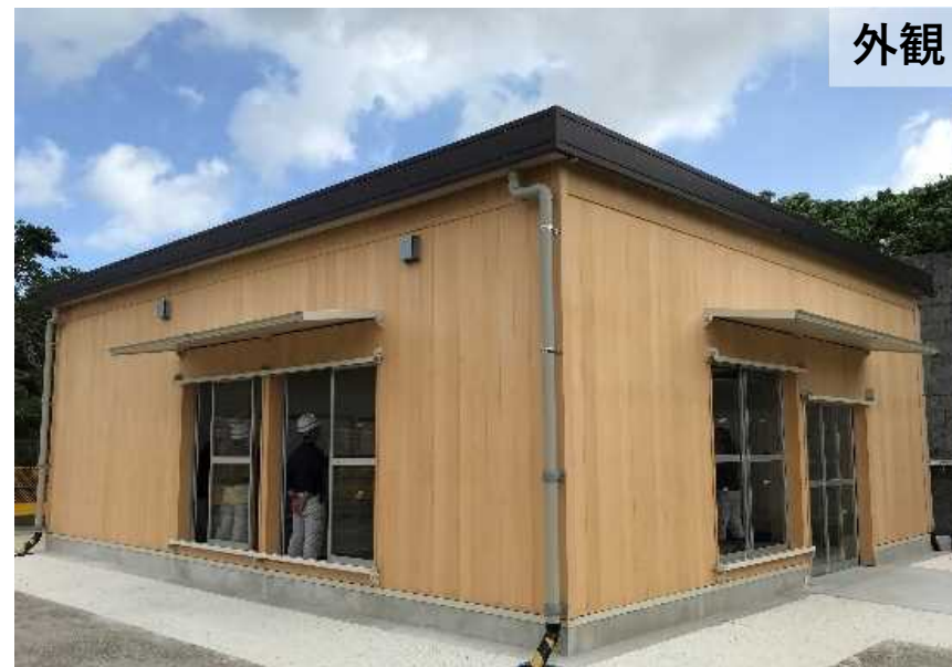
大龍柱補修作業場 (令和2年11月～ 展示等)
