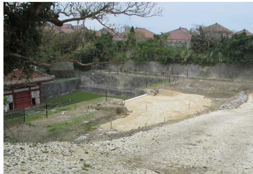
遺構保護（三門地区）
