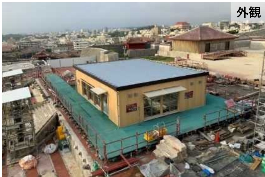
正殿遺構仮設覆屋 (令和2年6月12日～ 一般公開)
