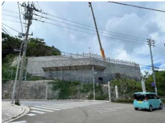
南城郭石積み（平成5～8年度復元）現況
