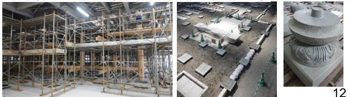
■素屋根見学エリア1階フロア【県産(与那国町)の礎石・礎盤の据え付け】
