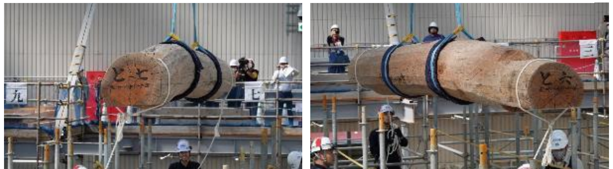
■素屋根見学エリア1階フロア【県産(与那国町)の礎石・礎盤の据え付け】
