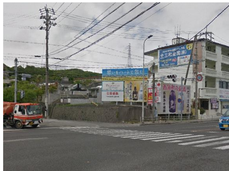
電線や広告看板による景観の阻害 (西原町内間)
