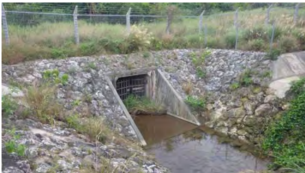
図 5.41 ボックスカルバート西側入り口 (撮影：平成 26 年 1 月 16 日)
