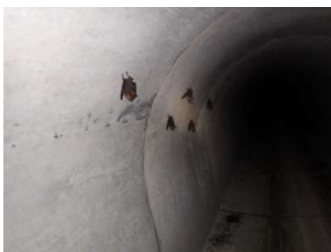
図 5.41 ボックスカルバート内のカグラコウモリ (撮影：平成 26 年 11 月 26 日)
