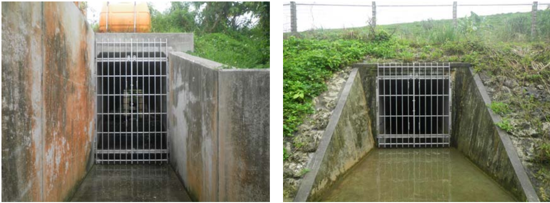
図 5.23 (1) ボックスカルバート出入口 (平成 28 年 3 月 22 日設置)
