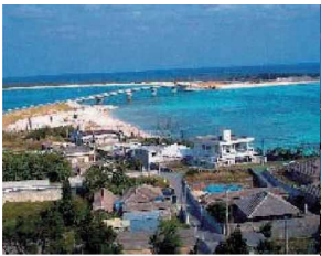
のほ 野甫大橋 ⑱
