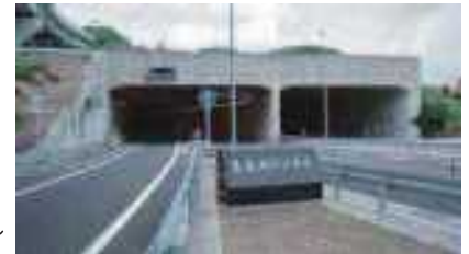
豊見城トンネル
