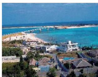
のほ 野甫大橋 ⑱
