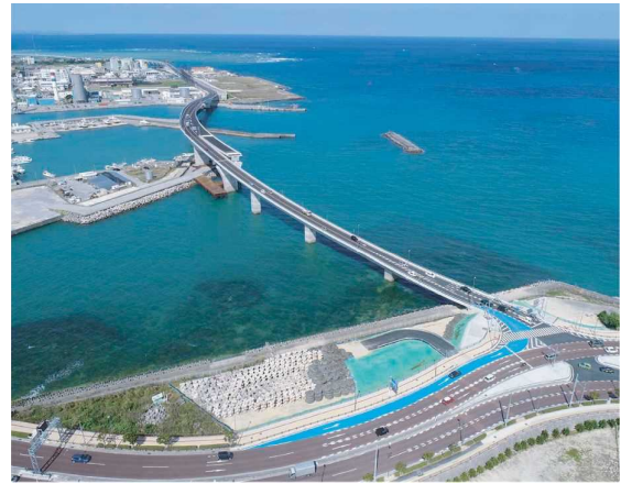
国道 58 号 浦添北道路
