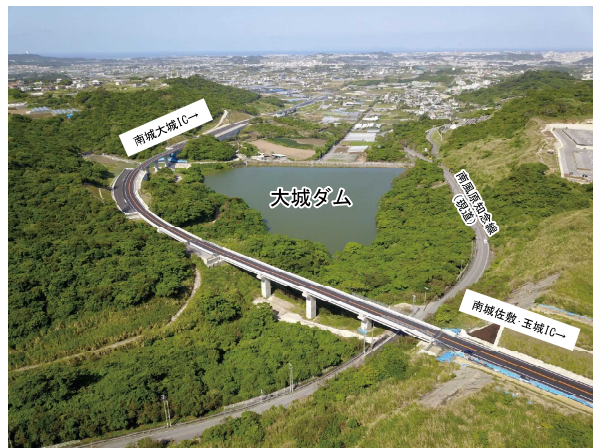
大城ダム付近
