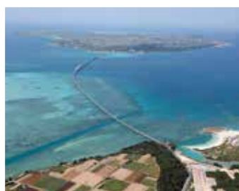
いらぶ 伊良部大橋 ㉑
