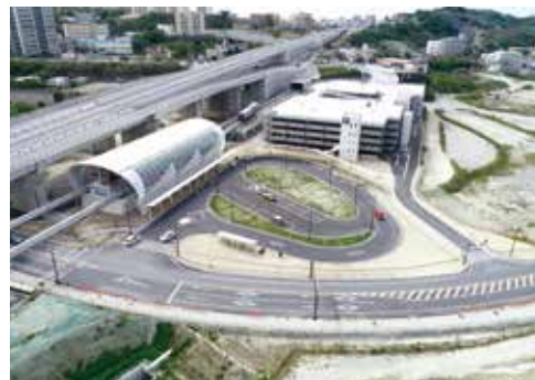
○沖縄都市モノレール延長整備事業 （てだこ浦西駅）
