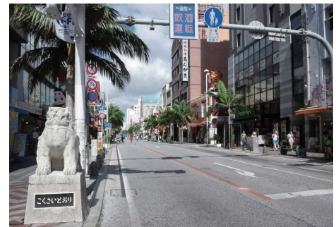
○街路整備事業（国際通り）
