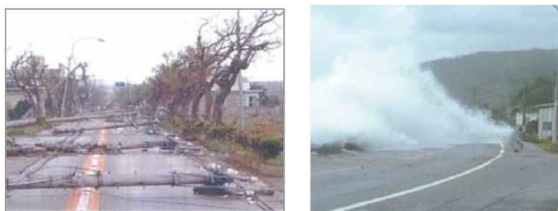
図 1-13 左：台風被害(宮古島)、右：越波状況(国頭村)
