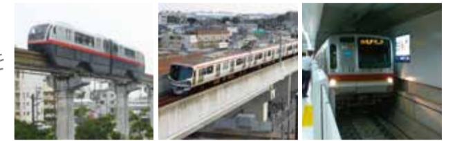
高架橋による専用軌道
