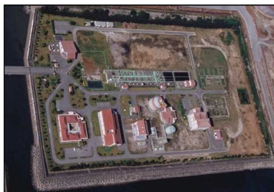
【西原浄化センター】
