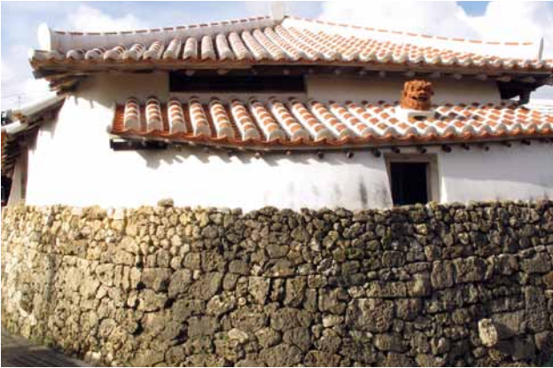
2段葺きとした赤瓦屋根とシーサー石垣塀（壁）と漆喰壁（新垣家住宅）
