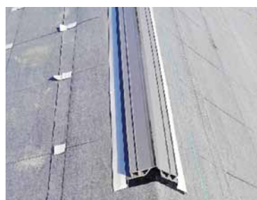
天井裏の換気を行う換気棟の設置
