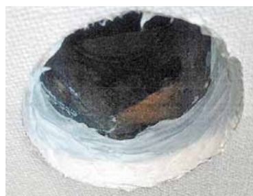
コーキング材による給気口の隙間処置
