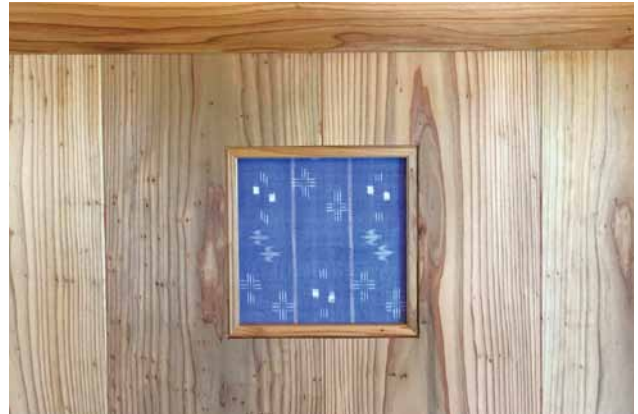
琉球がすりを建具の小窓にあしらう（染織物代用可）
