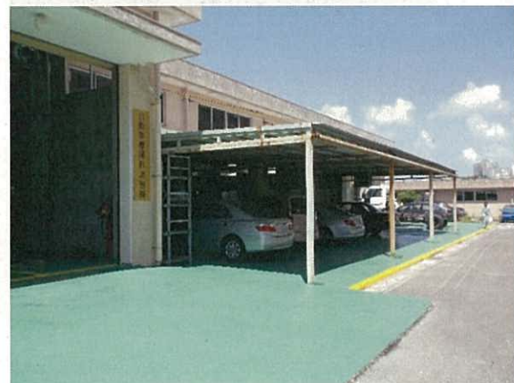
自動車整備科実習場
