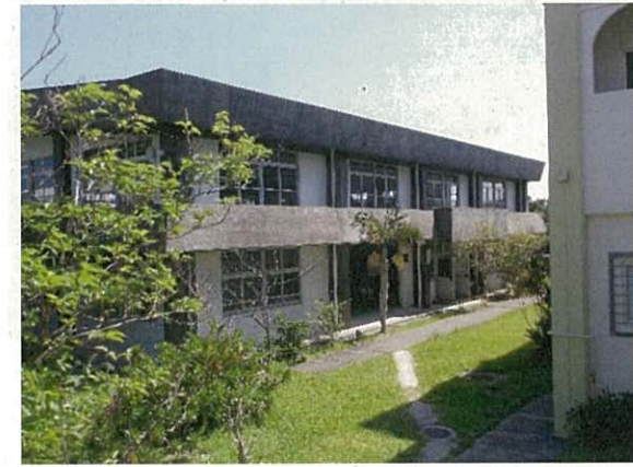
電気システム科実習棟
