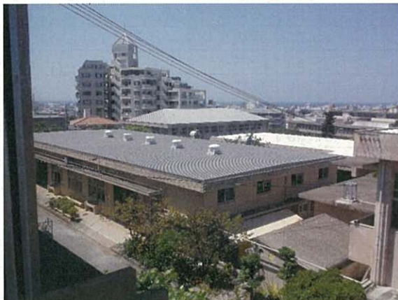
板金溶接科・設備システム科実習場
