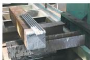
図2 切断前の鉄筋
