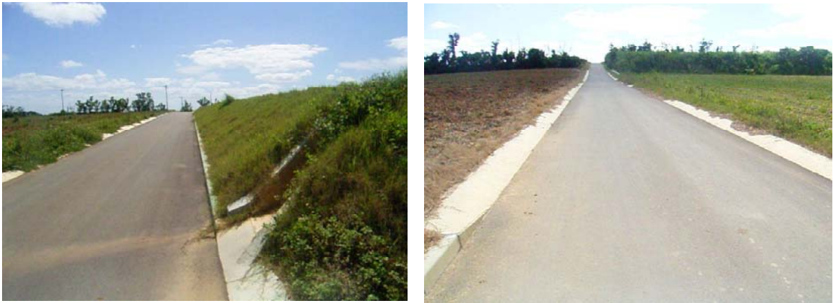
道路(路面, 側溝, 法面, 周囲)
