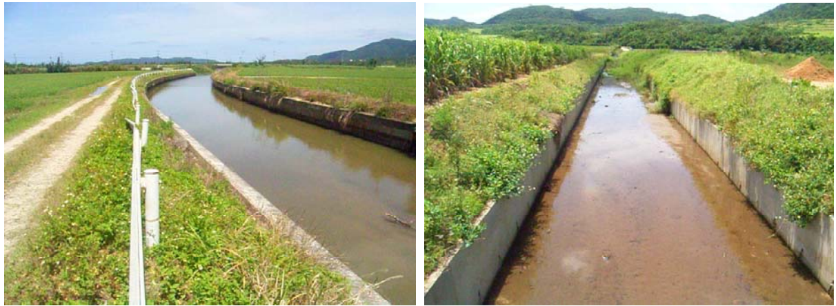
排水路(流路, 集水枳, 法面)
