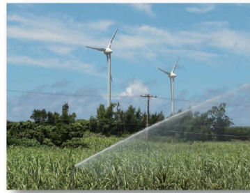
畑かん施設整備後(スプリンクラー)
