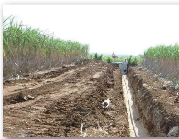
管路の布設作業
