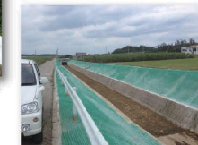
水利用調整・高産化支援事業による改修後の法面保護
