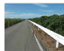
水利用調整・高産化支援事業による改修前の法面保護
