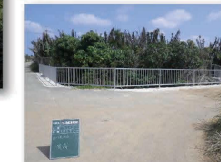
農業水利施設保全合理化事業による改修後のフェンス
