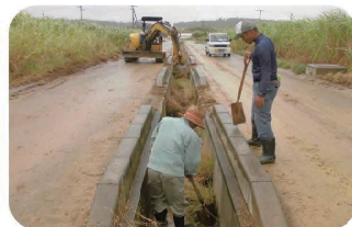
水路の泥上げ
